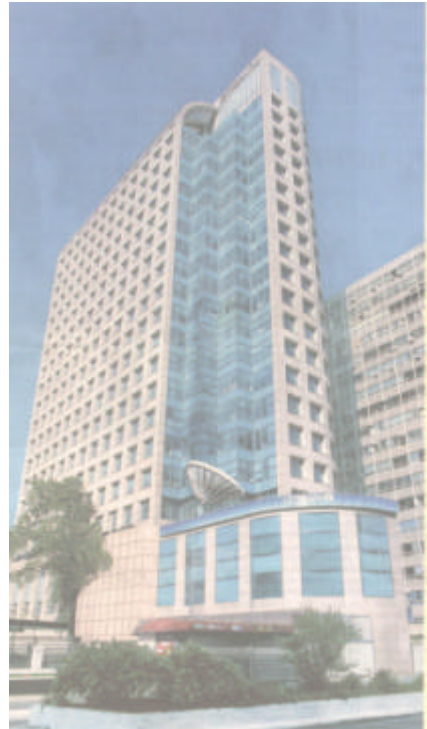
Edifício Citibank (década de 80)
