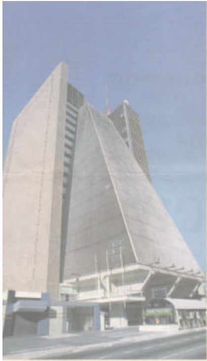
Edifício FIESP (década de 70)
