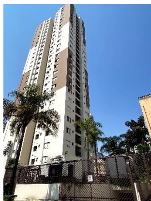
Figura 27: Empreendimento 3 – Condomínio edifício Saint Charbel (1998)
