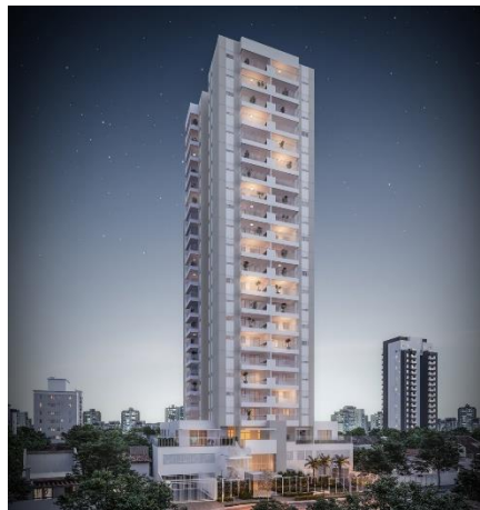
Figura 5: Edifício Petrus (Tatuapé)- ano 2020 (será entregue)
