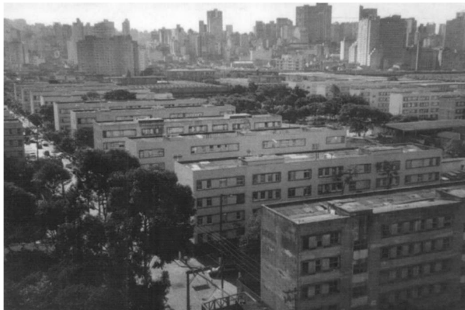
Figura 4 – Conjunto Residencial Várzea do Carmo (1938-1942), desenvolvido pelo IAPI Fonte: Cadernos de Habitação Coletiva (FAU-USP, 2014)
